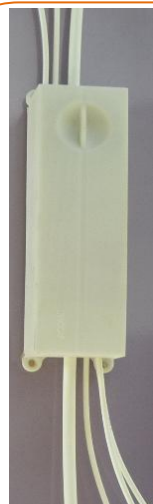
Exemple 1 : Be-box 24 installée dans une gaine technique
